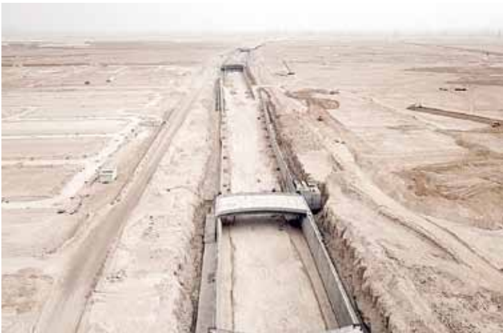
جانب من مشاريع الطرق في المطلاع
