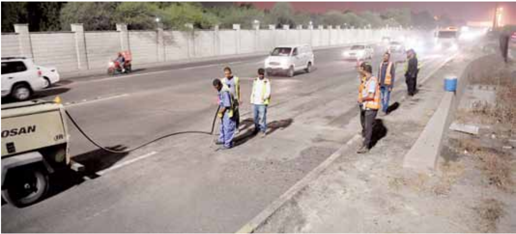
أعمال فرش الأسفلت في الطرق
